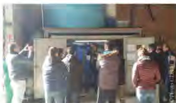
Visite Ego. Station de traitement de l'eau
